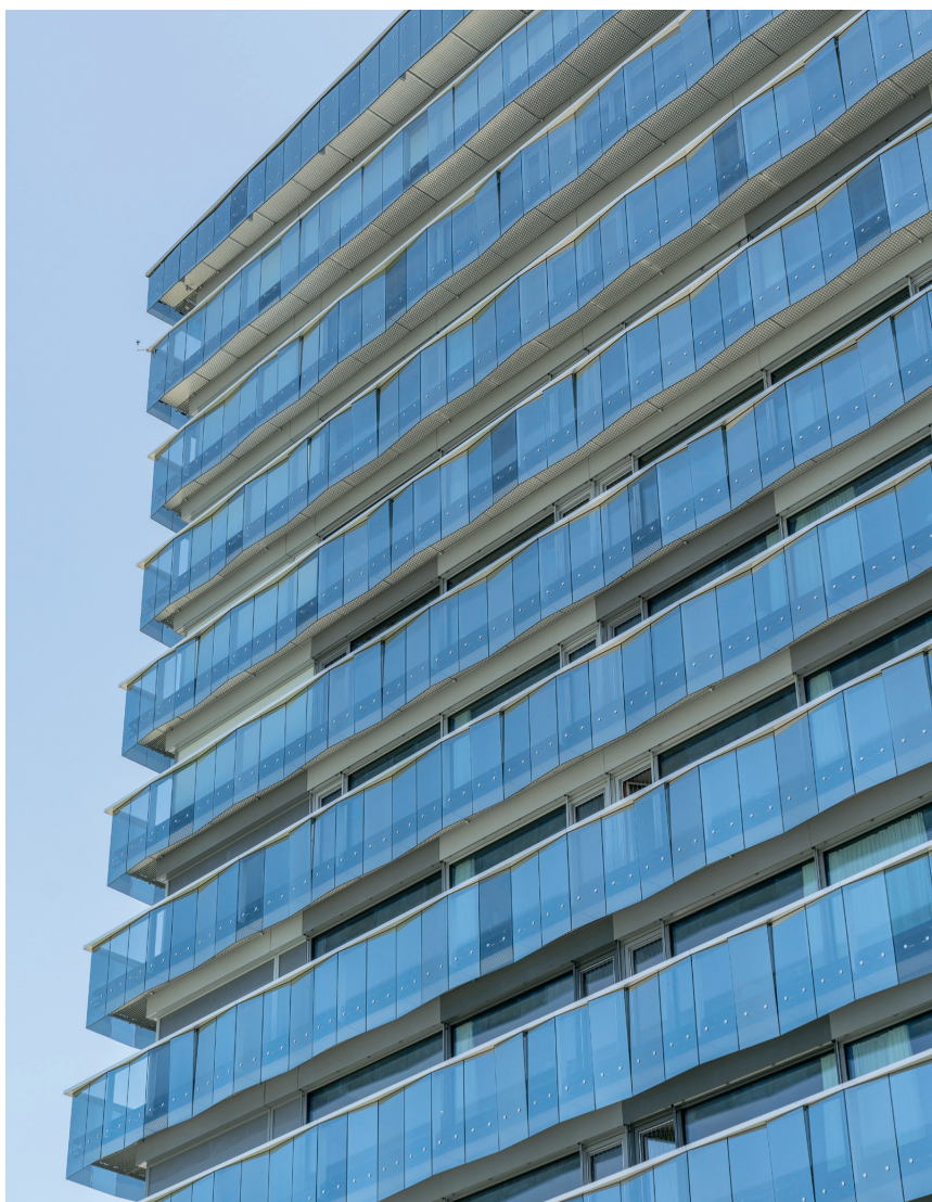
Beim Stadtspital Triemli führen in allen 18 Geschossen Laufstege mit Gitterrostböden um das Gebäude.
